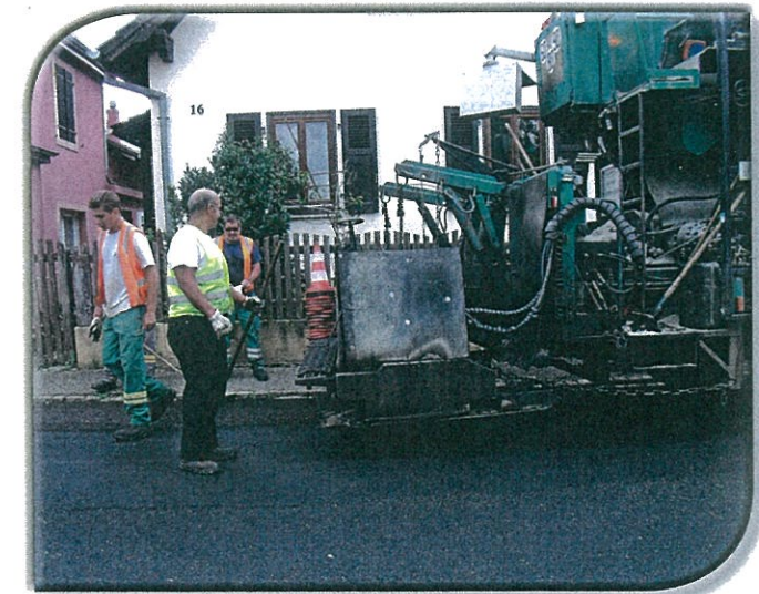
POSE D'UN ENROBÉ À FROID RUE DE GUEBWILLER
