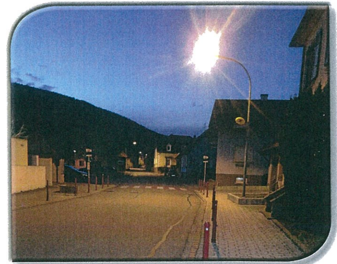
REPLACEMENT DES LAMPES SUR LES CANDÉLABRES DE LA RUE DE BERGHOLTZ-ZELL
