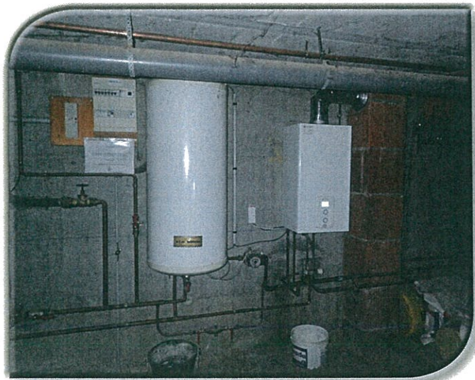
REPLACEMENT DES CHAUDIÈRES AU PRESBYTÈRE ET AU CLUB-HOUSE
