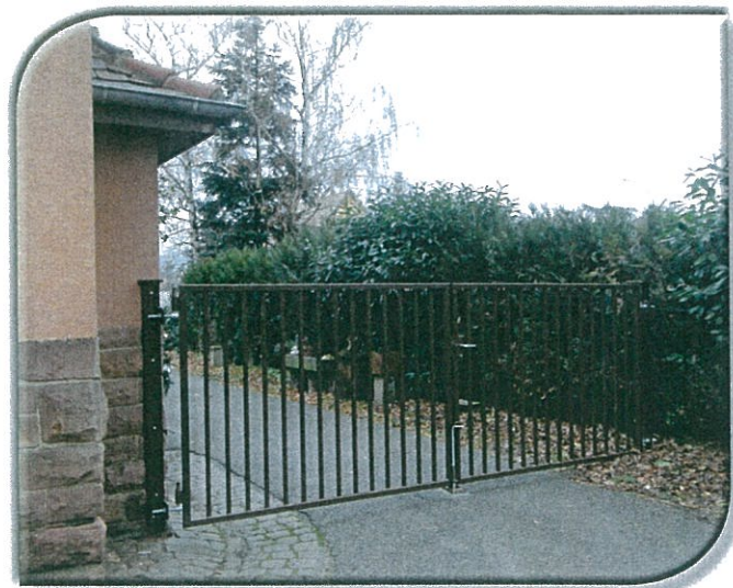
MISE EN PLACE D'UN PORTAIL DANS LA COUR DE L'ECOLE ELEMENTAIRE
