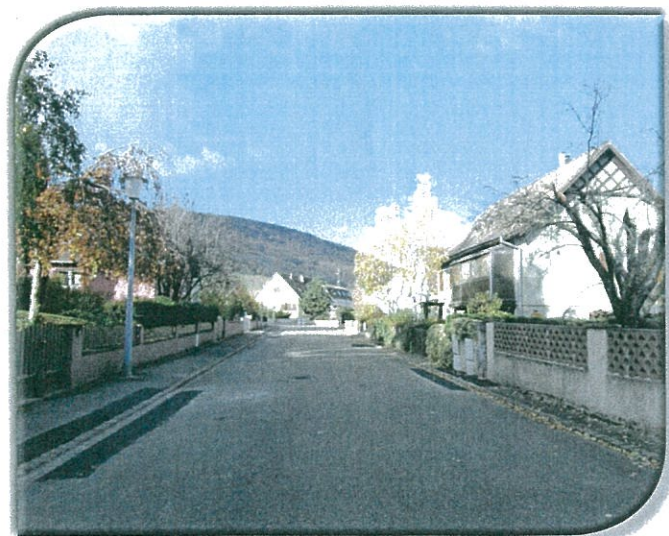
TRAVAUX D'ENTRETIEN DE VOIRIE : RUE DE MURBACH
