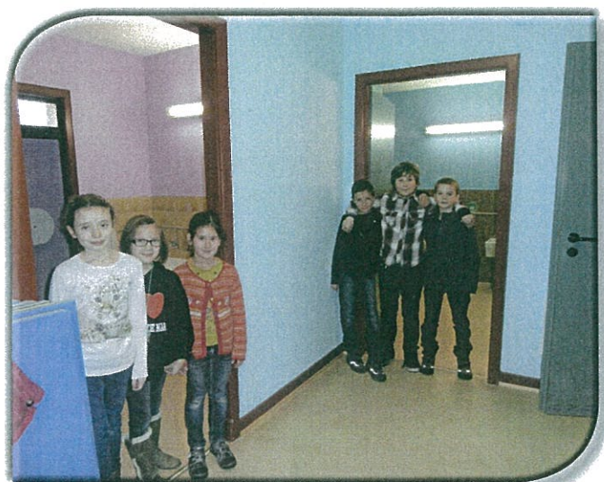
REMPACEMENT DU REVETEMENT DES SOLS DANS LE COULOIR ET LES SANITAIRES
